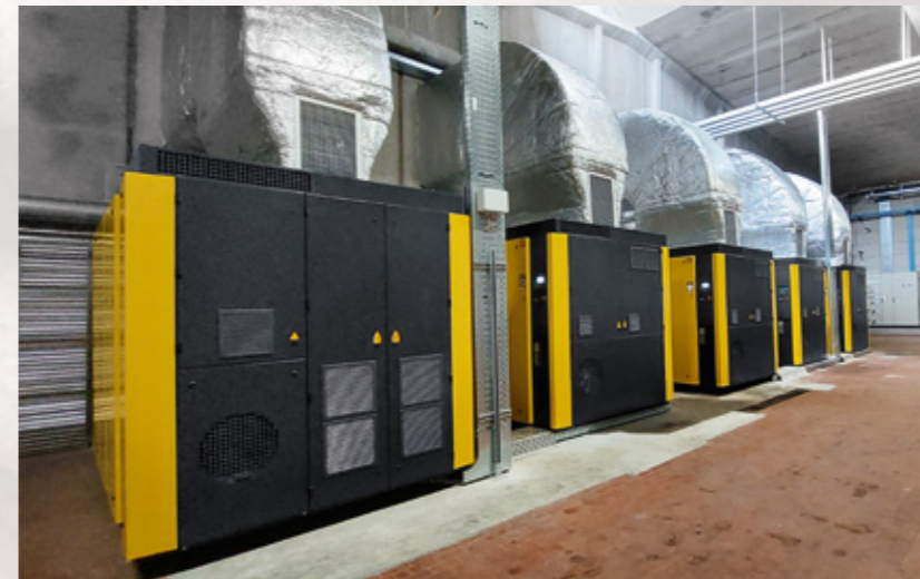
Kuva vasemmalla: Cervotessile tunnetaan laadukkaista tuotteistaan, joista kirjoitetaan unohtumattomia tekstiilitarinoita. Kuva oikealla: Uusi paineilma-asema koostuu viidestä Kaeserin ruuvikompressorista.
