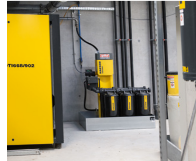
Uusi Aquamat i.CF on ensimmäinen älykäs öljyn ja veden erotin.
